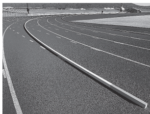
全線に設置した代用縁石(図3)
